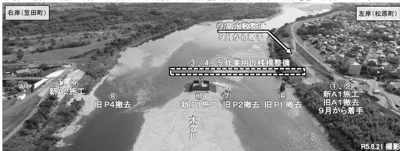
※旧P3橋脚、旧A2橋台は撤去完了
