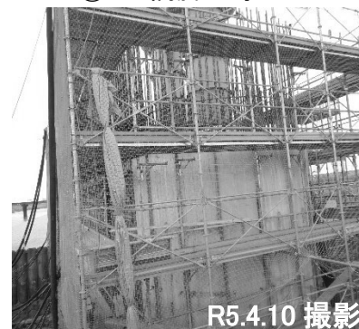
▼④P1 橋脚工事
