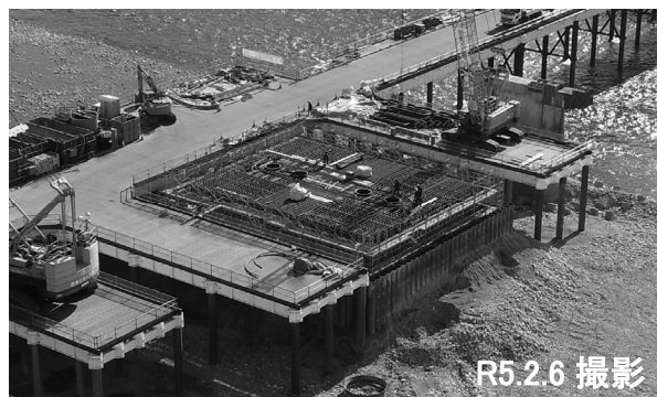
⑥P1 橋脚施工状況
