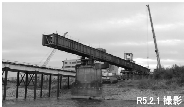
①車道桁撤去完了
