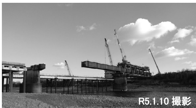
①車道桁撤去状況
