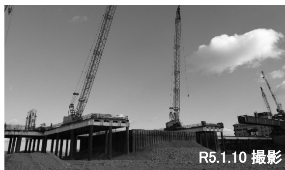
⑥P1橋脚工事状況
