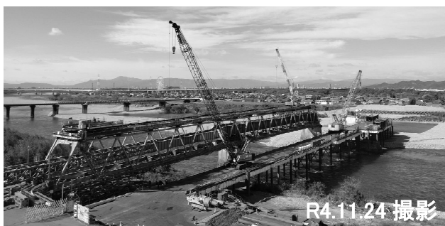
①②仮栈橋及び車道桁の施工状況
