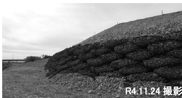
③盛土の施工状況
