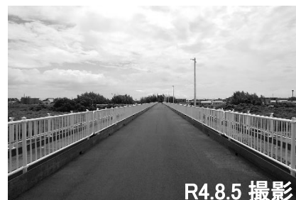
⑥⑨仮橋上施工状況
