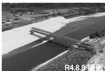
②歩道桁撤去状況
