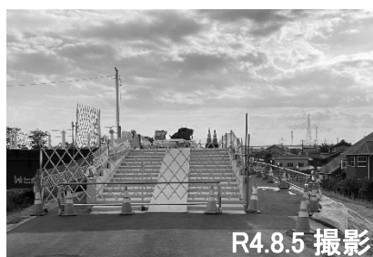
⑦右岸スロープ施工状況
