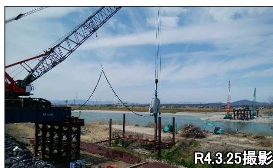
仮橋 支持杭打ち込み
