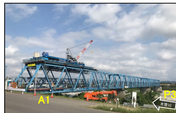
トラベラークレーン設置状況
