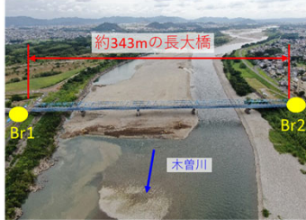
1級河川に架かる川島大橋
