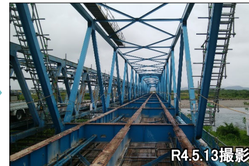
A1-P3床版撤去
