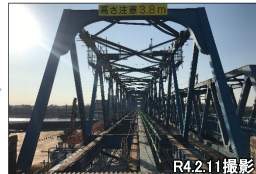
P3-A2床版撤去
