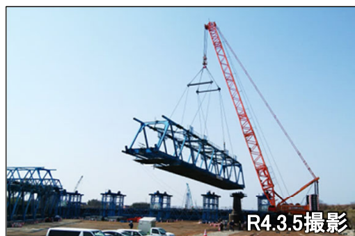
P3-A2橋桁撤去
