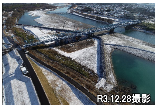
瀬替え(右岸 → 左岸) 作業ヤード造成
