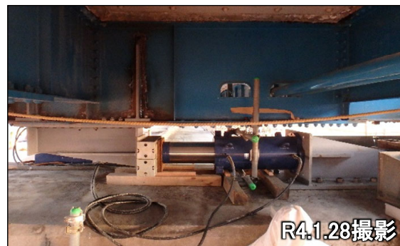
水平力除去作業
