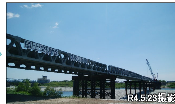
応急組立橋架設
