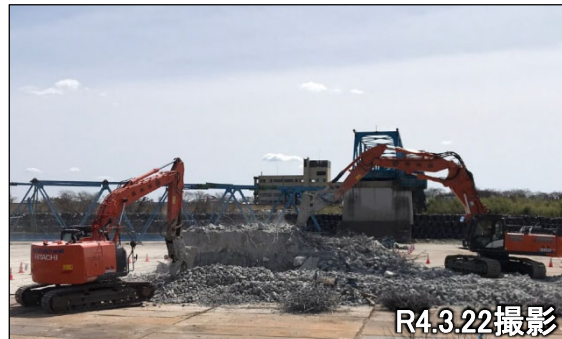
P4橋脚撤去
