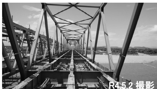
① コンクリート床版の撤去
