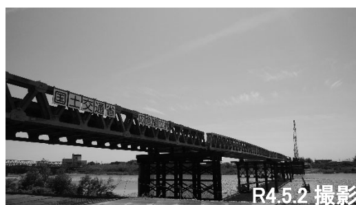
③ 応急組立橋の架設
