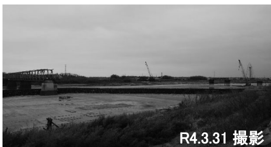
② 橋脚の撤去
