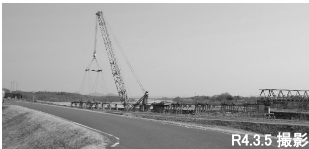
①橋桁の撤去
