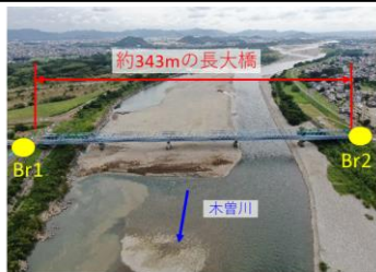
1級河川に架かる川島大橋
