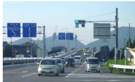
写真 太田町交差点の渋滞状況 H26.9撮影(車線拡幅後)
