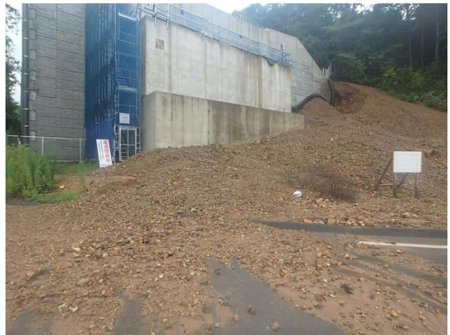
擁壁背面盛土の土砂流出 約150m<sup>3</sup> 等
