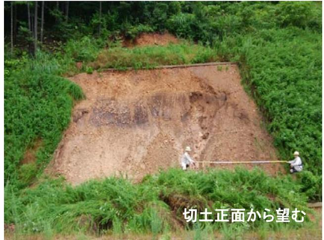
土砂流出 300m<sup>3</sup> (幅15m×高さ15m)
