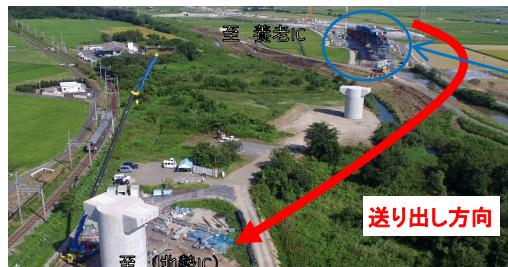
津屋川・養老鉄道をまたぐ現場にて、長さ約80m、幅約11m、重さ約750トンの橋桁をワイヤーなどで引っ張り、1分間に50センチずつ、ゆっくりと送り出し架設されています。
