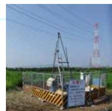
地質調査の状況
