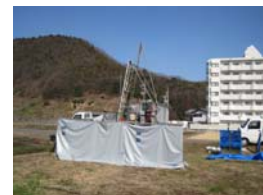
地質調査の状況
