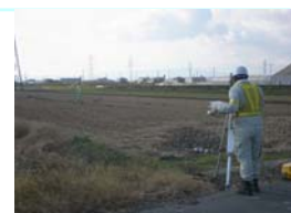
用地幅杭設置の状況
