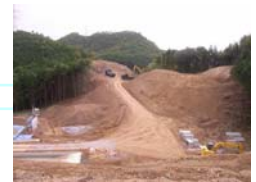
土工工事の状況
