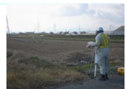
用地幅杭設置の状況
