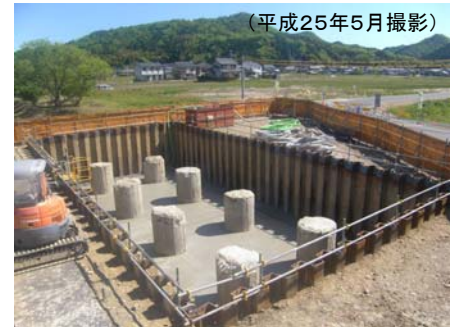
下部工事の状況
