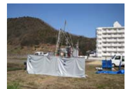
地質調査の状況
