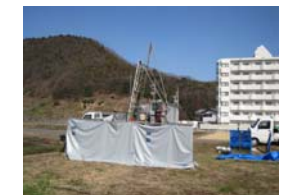
地質調査の状況
