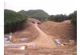
土工工事の状況
