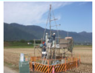
地質調査の状況
