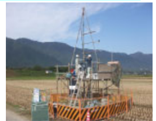
地質調査の状況
