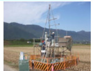
地質調査の状況
