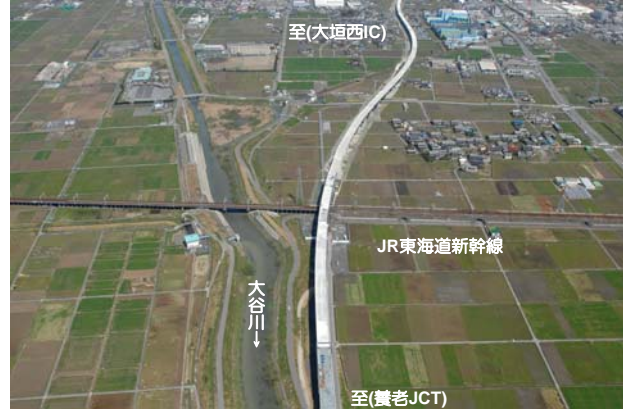
大垣市綾野地区の状況、南から北を望む (平成24年4月12日撮影)
