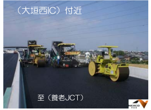
本線舗装工事状況、(大垣西IC)方面を望む (平成24年5月21日撮影)
