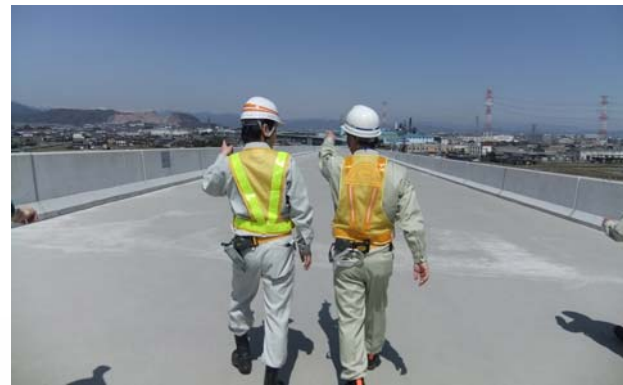
合同点検の状況、綾野地区の南から北を望む(平成24年3月29日撮影) (左側)山口中日本高速道路(株)岐阜工事事務所長、(右側)福島岐阜国道事務所長
