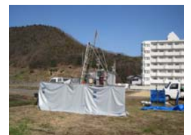
地質調査の状況
