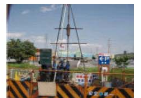
地質調査の状況
