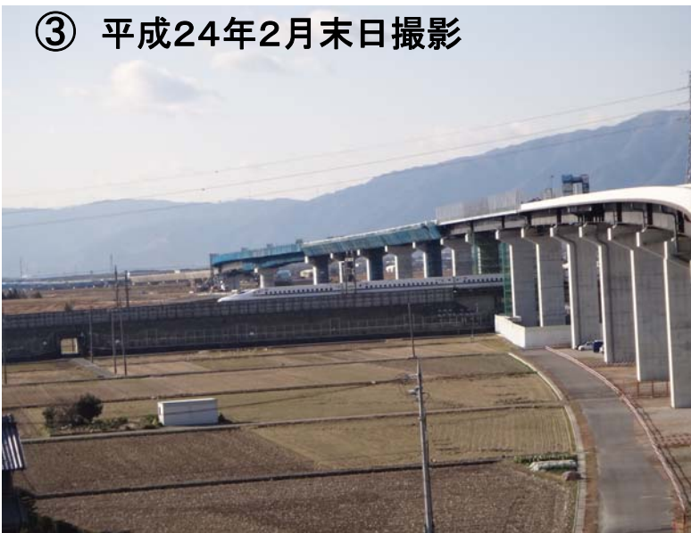
綾野地区から養老JCT方面を望む
