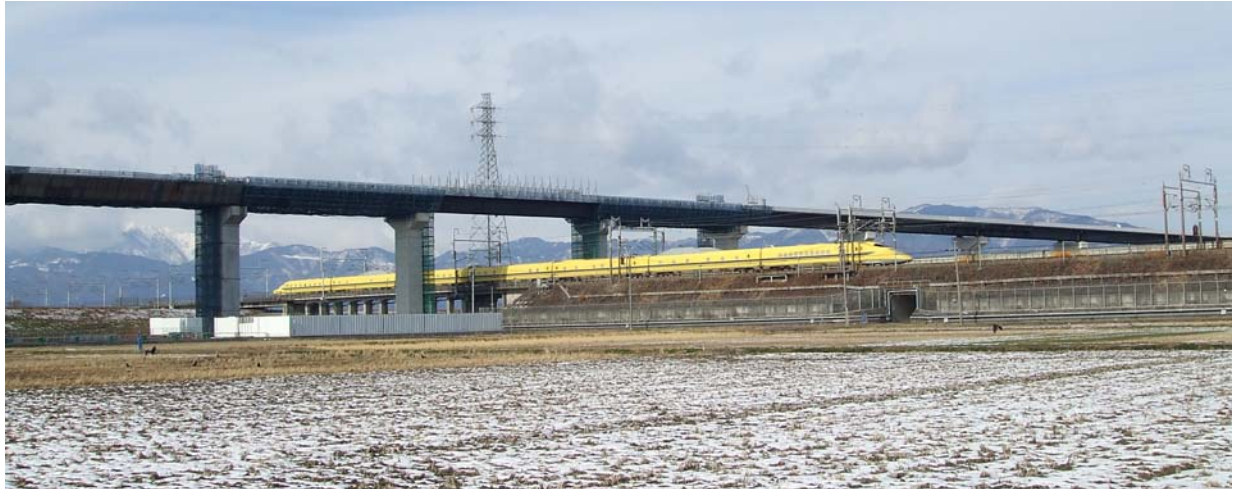
①大垣市綾野地区の工事状況(JR新幹線の南側から北西方向を望む、平成23年12月28日撮影)
