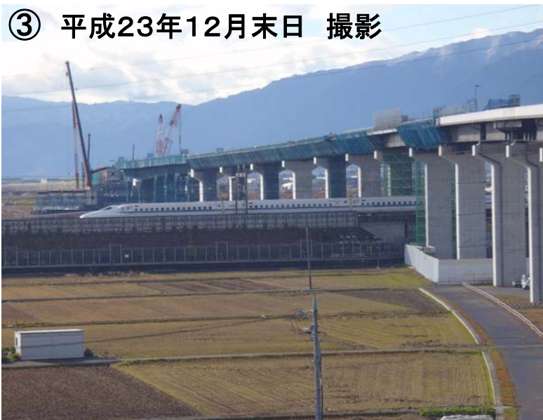
綾野地区から養老JCT方面を望む
