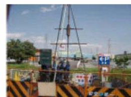
地質調査の状況
