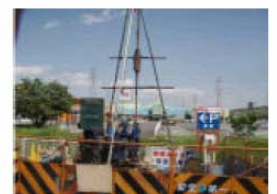
地質調査の状況
