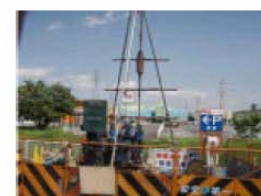
地質調査の状況
