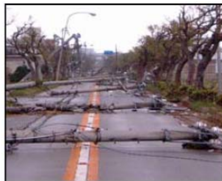
台風によって電柱が道路を塞いだ例
