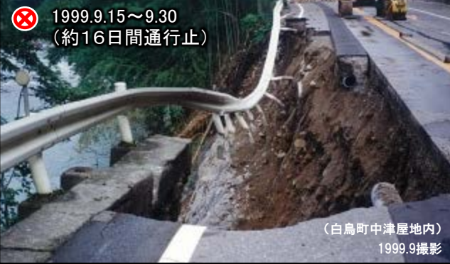
写真① 路面崩落の発生状況
