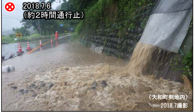
写真② 土砂流出の発生状況
