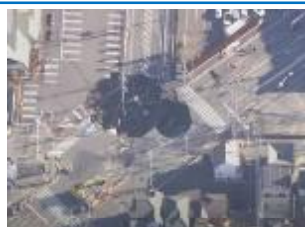
1月31日時点の事故現場の状況
