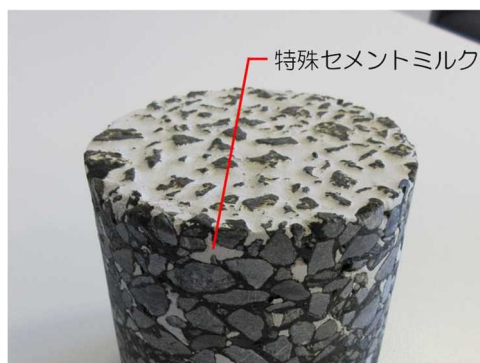
付図 1. 2. 4. 1 半たわみ性舗装のコアの事例
