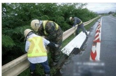
<防護柵の取替>
