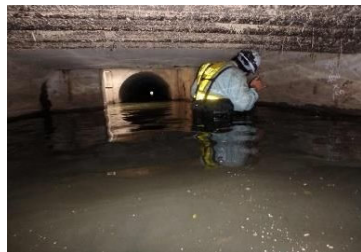
滞水した溝橋内部の目視点検
