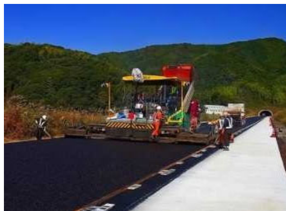
付図 1.1.3.1 コンポジット舗装の施工状況
