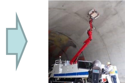
レーザー打音による変状の把握
