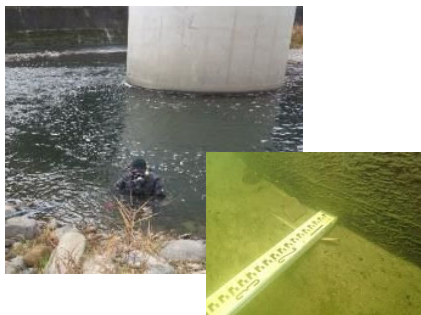
潜水調査による河床洗掘の把握
