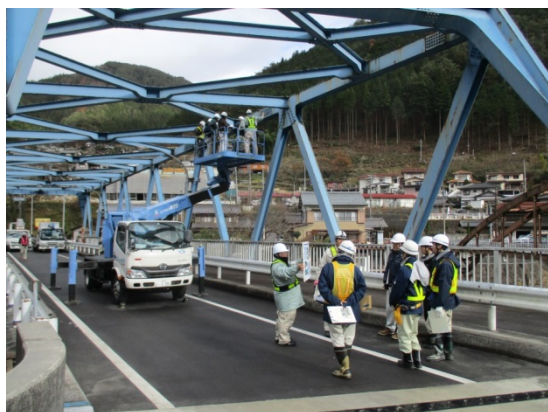
点検対象橋梁(帯雲橋)
