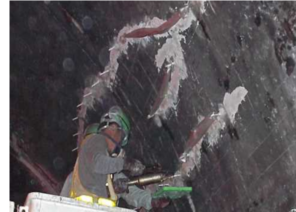
トンネル補修
