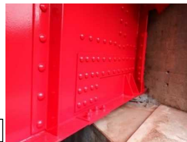
桁端部の当て板・塗装
