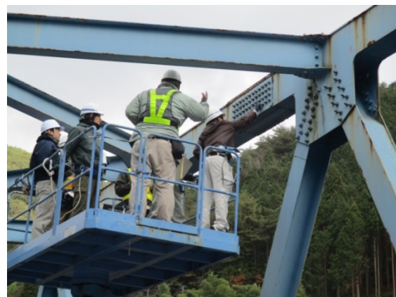
高所作業車による点検状況
