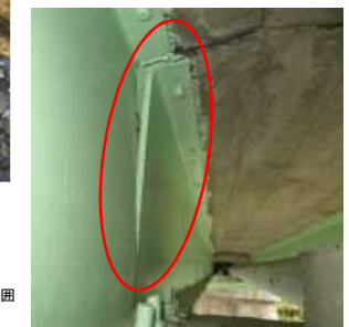
主桁の変形
