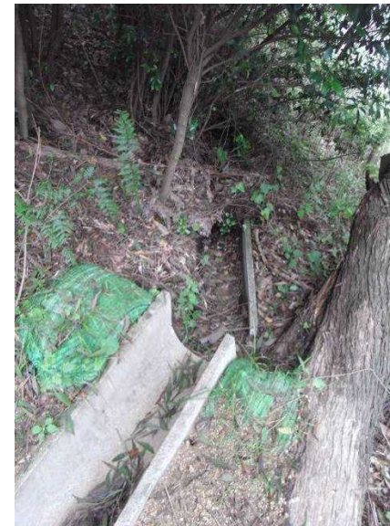
写真 排水溝の破損の例
