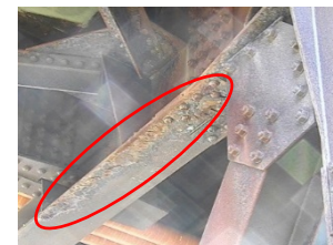
耐候性鋼材に層状の剥離
