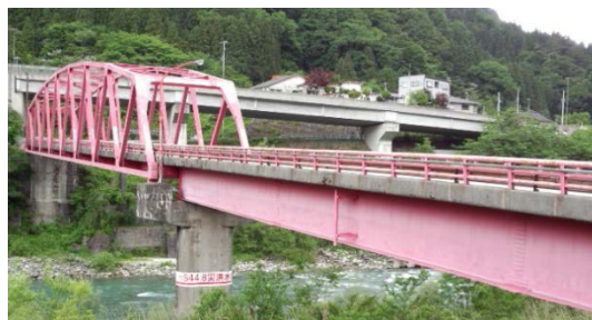
<音沢橋の状況>
