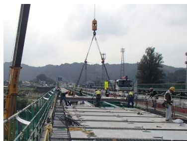
プレキャスト床版による 打ち替え
