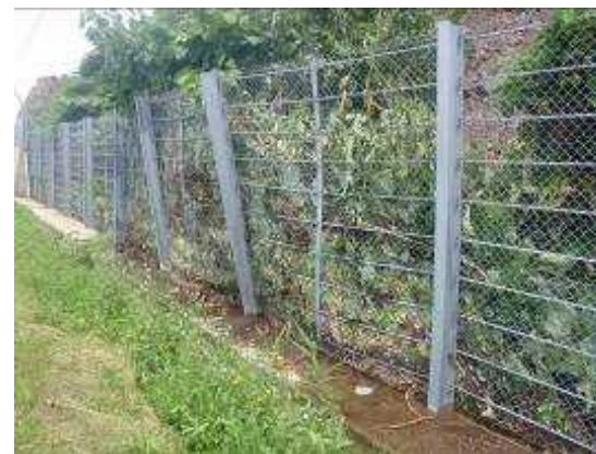
写真 落石防護柵の傾動の例
