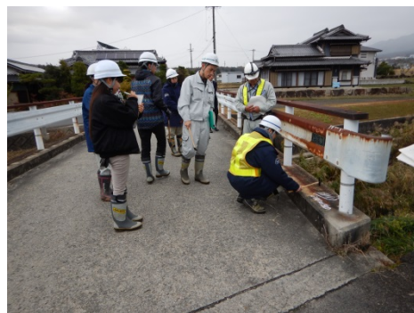
点検ハンマーで地覆部コンクリートの「浮き」を打音確認している様子。
