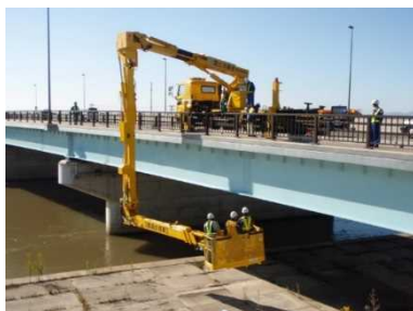
橋梁点検車による点検
