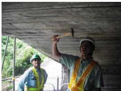
目視及びハンマーによる打音検査
