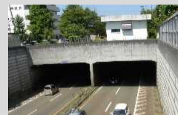
大型ボックスカルバート
