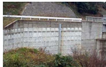
盛土(補強土壁)
