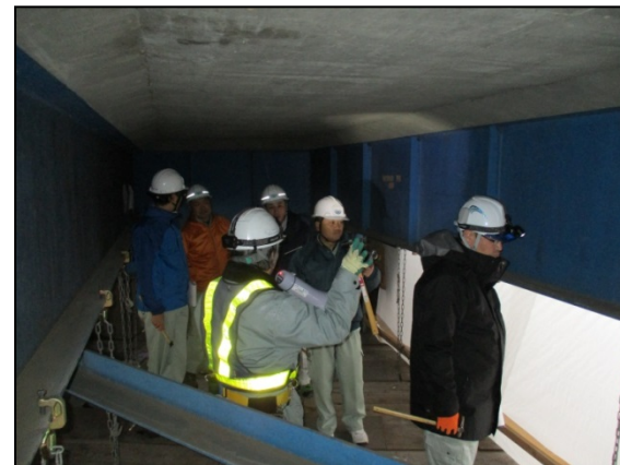
工事用足場を用いた点検状況
