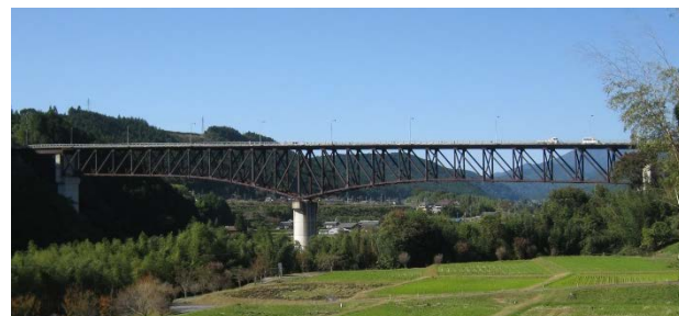
<乙姫大橋の状況>
