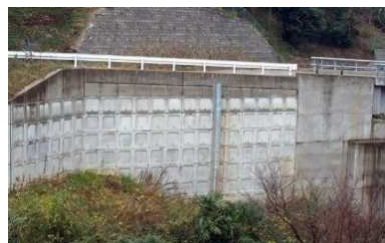
盛土（補強土壁）
