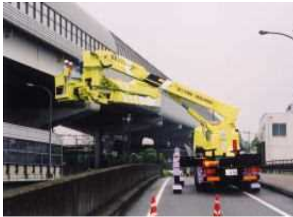
橋梁等構造物の点検
