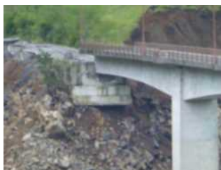
斜面変状による橋台の沈下
