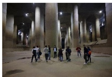
インフラツーリズム (首都圏外郭放水路)
