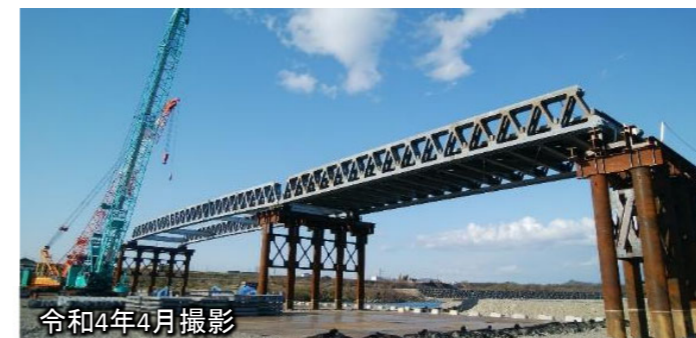
<右岸側> 応急組立橋の施工状況
