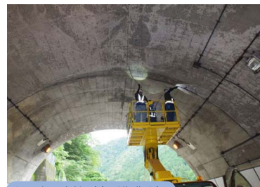
トンネル点検（高所作業車）
