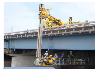
橋梁点検（橋梁点検車）
