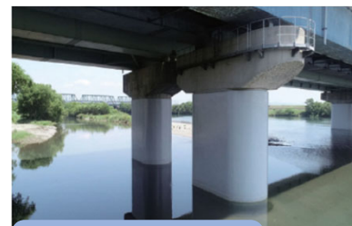
橋脚補強(コンクリート巻き立て)
