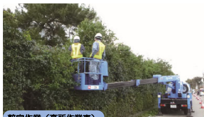
剪定作業（高所作業車）
