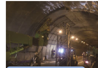
トンネル修繕（剥離防止ネット設置）
