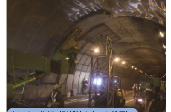
トンネル修繕（剥離防止ネット設置）
