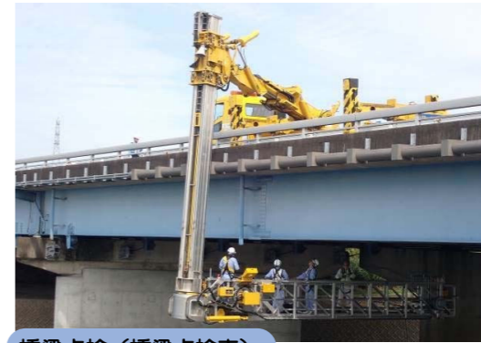
橋梁点検（橋梁点検車）
