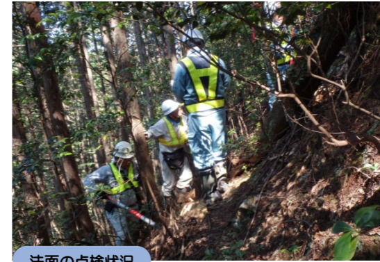
法面の点検状況
