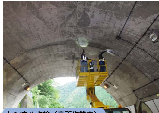
トンネル点検（高所作業車）
