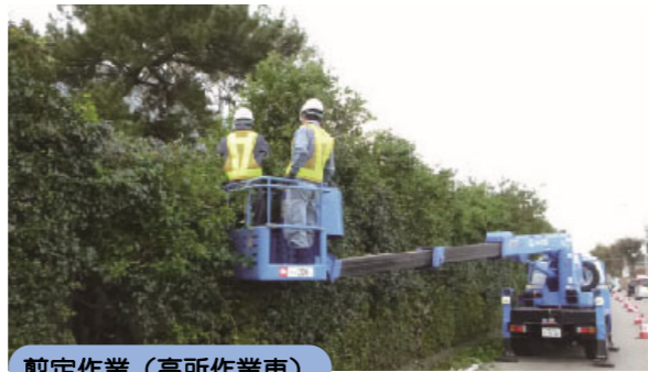
剪定作業（高所作業車）
