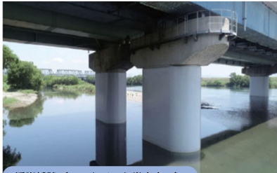
橋脚補強（コンクリート巻き立て）
