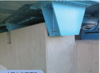
水平力分担構造
