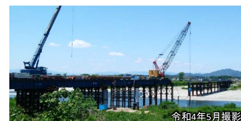
＜左岸側＞仮橋の施工状況
