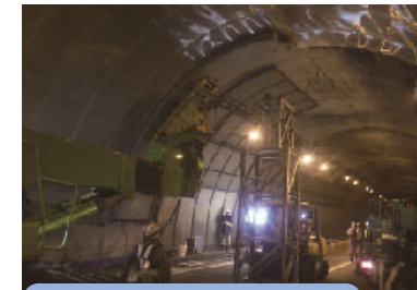
トンネル修繕（剥離防止ネット設置）
