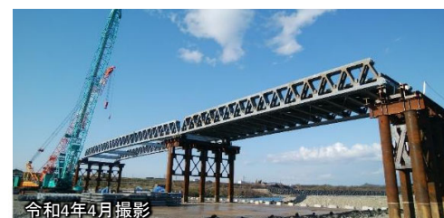
＜右岸側＞応急組立橋の施工状況
