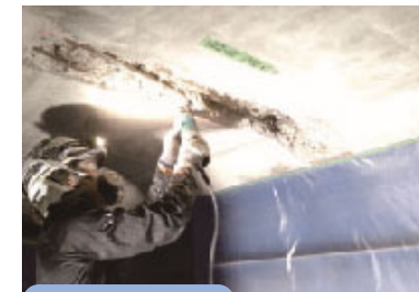
橋梁修繕（断面修復）
