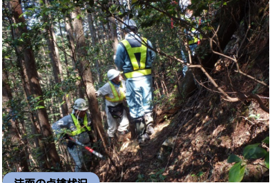
法面の点検状況
