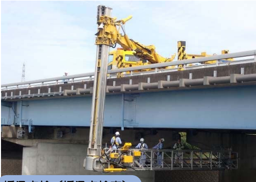
橋梁点検（橋梁点検車）
