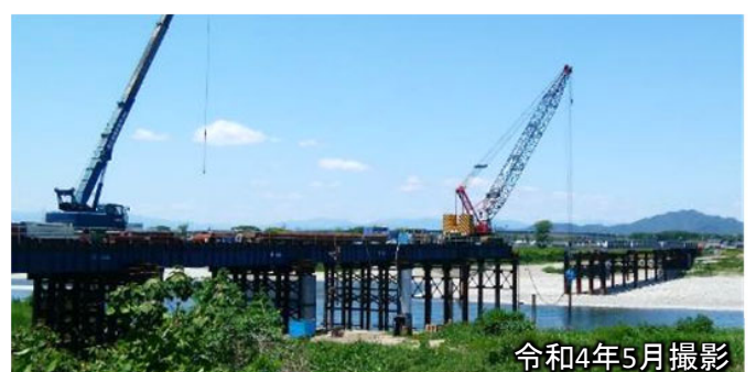
＜左岸側＞仮橋の施工状況
