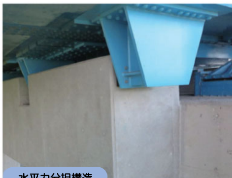
水平力分担構造
