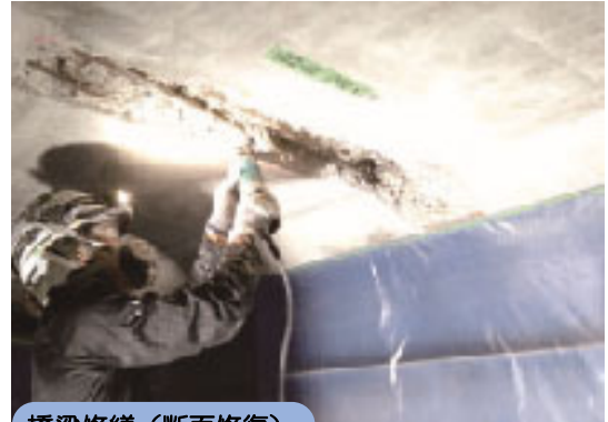
橋梁修繕（断面修復）
