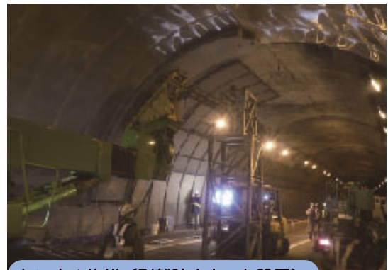
トンネル修繕（剥離防止ネット設置）
