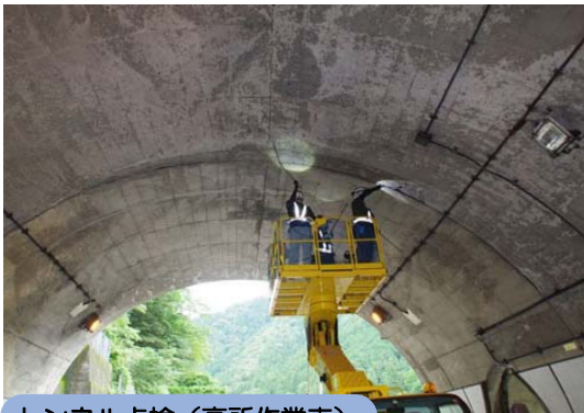
トンネル点検（高所作業車）
