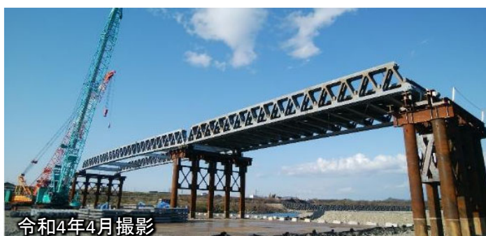
＜右岸側＞応急組立橋の施工状況
