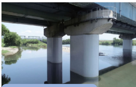
橋脚補強（コンクリート巻き立て）
