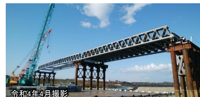
＜右岸側＞応急組立橋の施工状況
