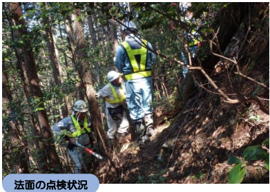
法面の点検状況
