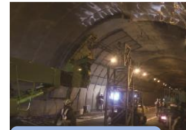
トンネル修繕（剥離防止ネット設置）
