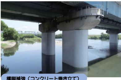
橋脚補強 (コンクリート巻き立て)
