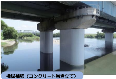
橋脚補強（コンクリート巻き立て）
