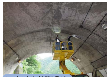
トンネル点検（高所作業車）
