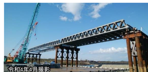
＜右岸側＞応急組立橋の施工状況
