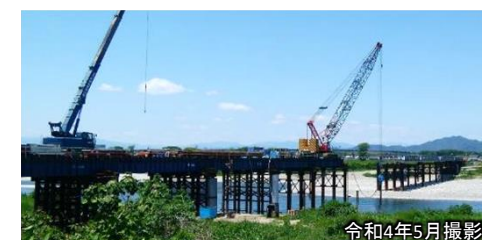
＜左岸側＞仮橋の施工状況
