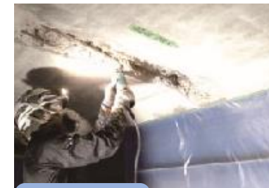
橋梁修繕（断面修復）
