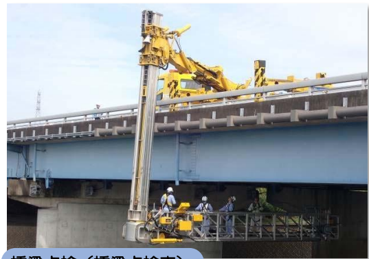
橋梁点検（橋梁点検車）
