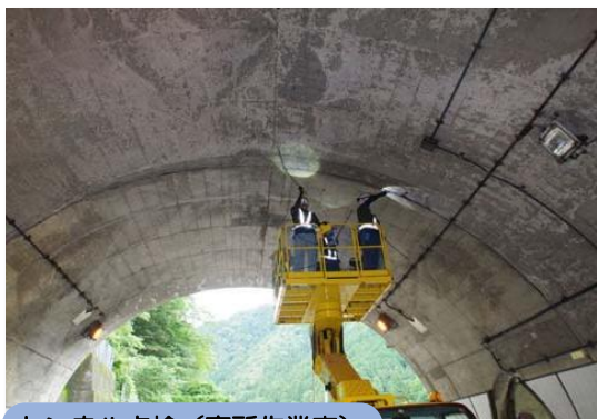
トンネル点検（高所作業車）
