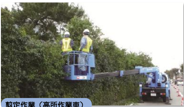
剪定作業（高所作業車）
