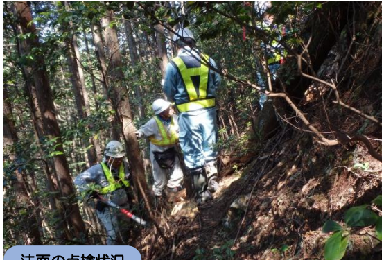
法面の点検状況
