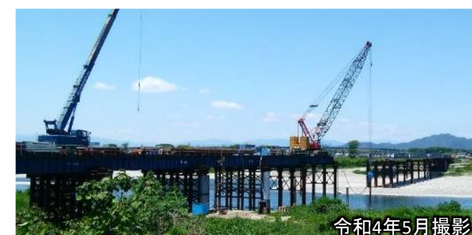
＜左岸側＞仮橋の施工状況
