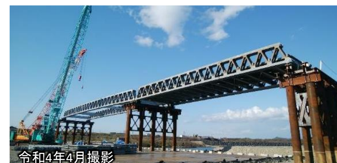
＜右岸側＞応急組立橋の施工状況
