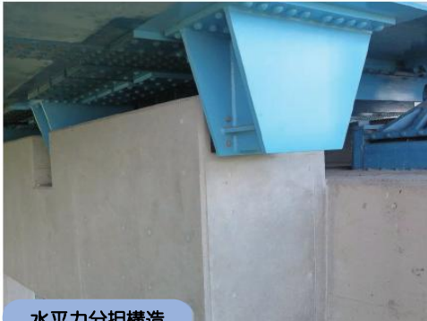
水平力分担構造
