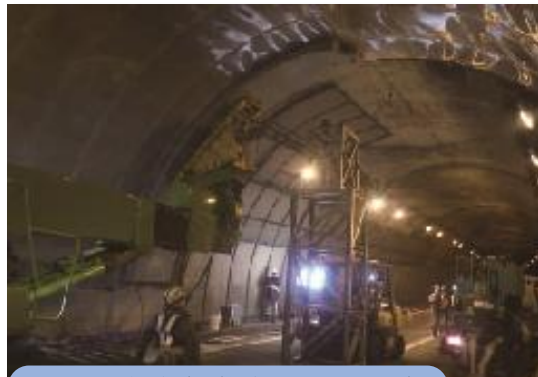
トンネル修繕（剥離防止ネット設置）
