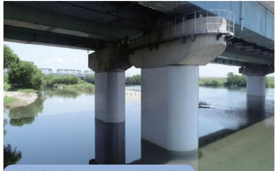
橋脚補強（コンクリート巻き立て）
