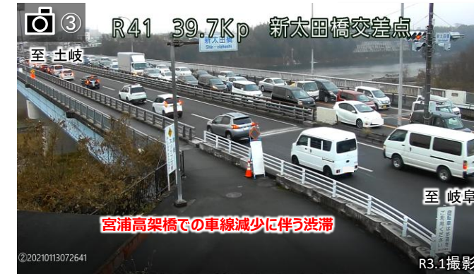
□新太田橋交差点（南側流入部）
