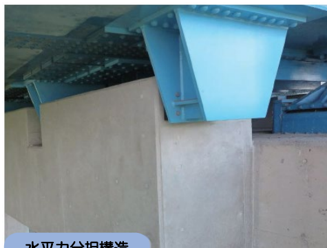
水平力分担構造
