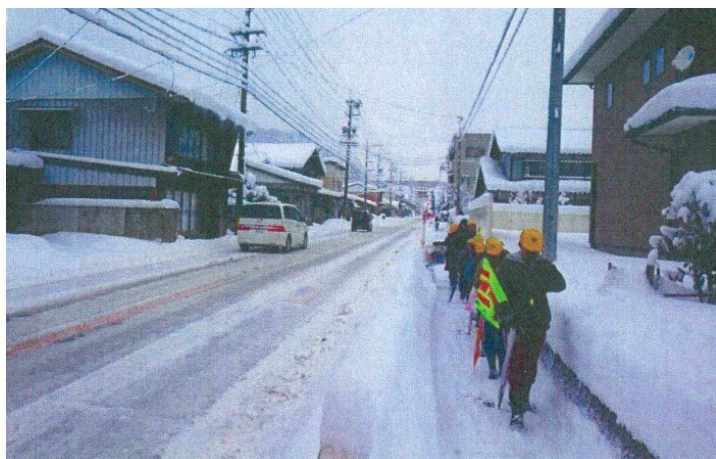
156大島歩道整備 (郡上市白鳥町)
