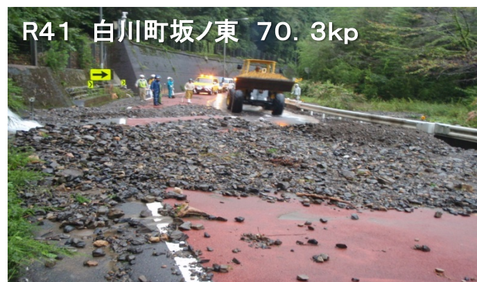
H23.9法面崩落状況(白川町坂ノ東)
