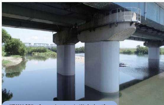
橋脚補強（コンクリート巻き立て）
