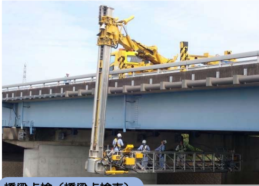
橋梁点検（橋梁点検車）
