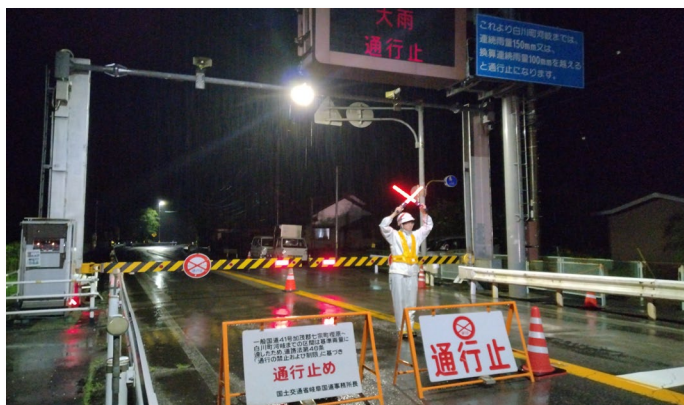
R5.5雨量通行止め状況(七宗町榎原)
