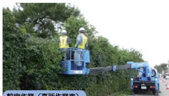
剪定作業（高所作業車）
