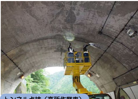
トンネル点検（高所作業車）
