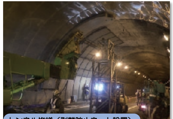
トンネル修繕（剥離防止ネット設置）
