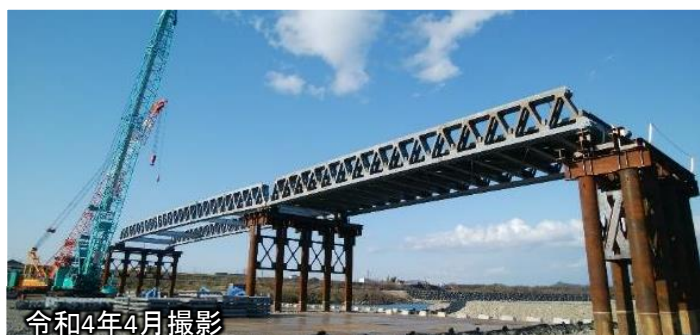
＜右岸側＞応急組立橋の施工状況
