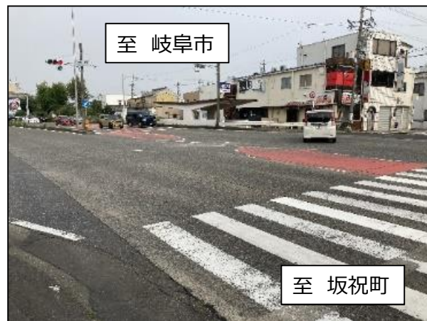
21号那加大東町交差点改良 (各務原市那加大東町)
