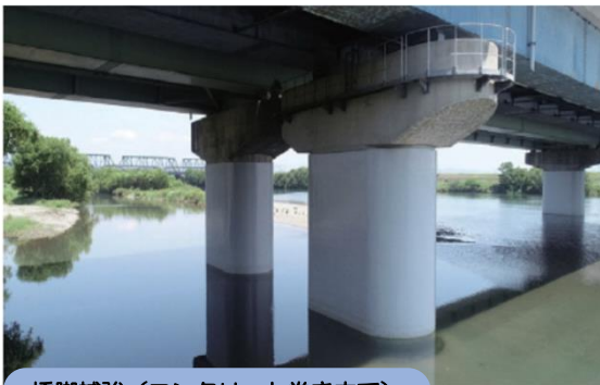
橋脚補強（コンクリート巻き立て）
