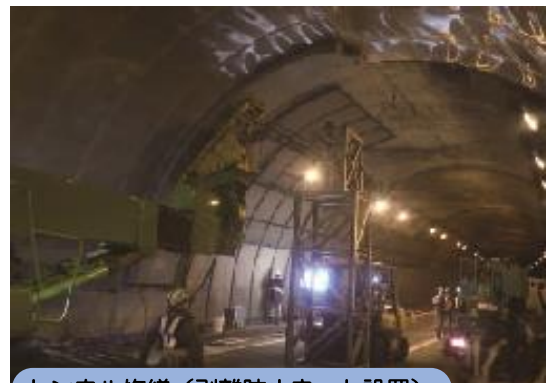
トンネル修繕（剥離防止ネット設置）
