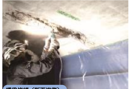
橋梁修繕（断面修復）
