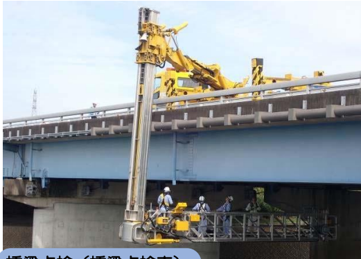
橋梁点検（橋梁点検車）
