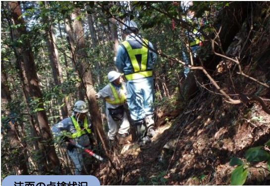
法面の点検状況
