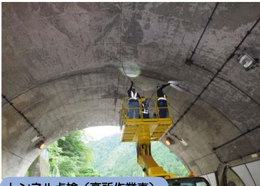
トンネル点検（高所作業車）
