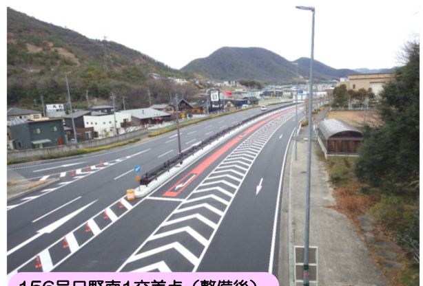
156号日野南1交差点（整備後）
