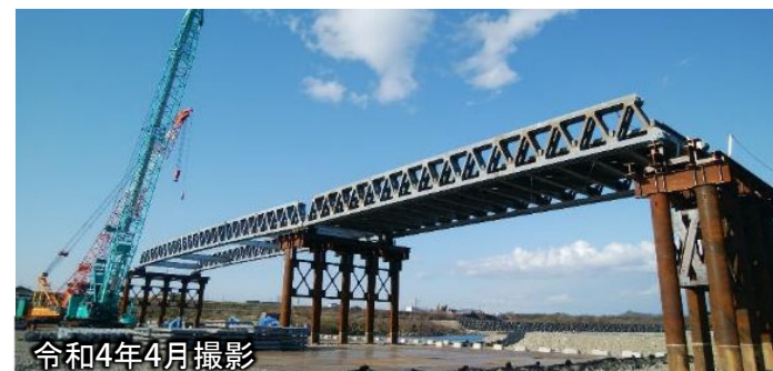
<右岸側> 応急組立橋の施工状況
