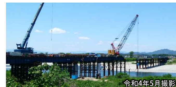
<左岸側> 仮橋の施工状況
