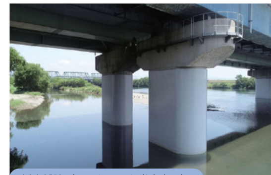
橋脚補強（コンクリート巻き立て）
