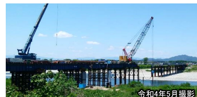
＜左岸側＞仮橋の施工状況
