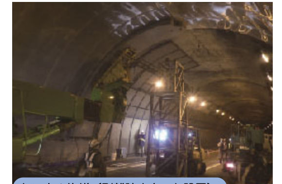
トンネル修繕（剥離防止ネット設置）
