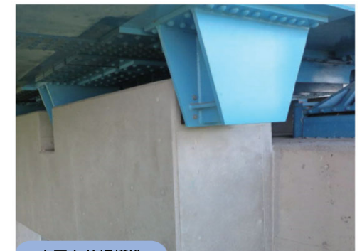
水平力分担構造
