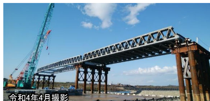
＜右岸側＞応急組立橋の施工状況
