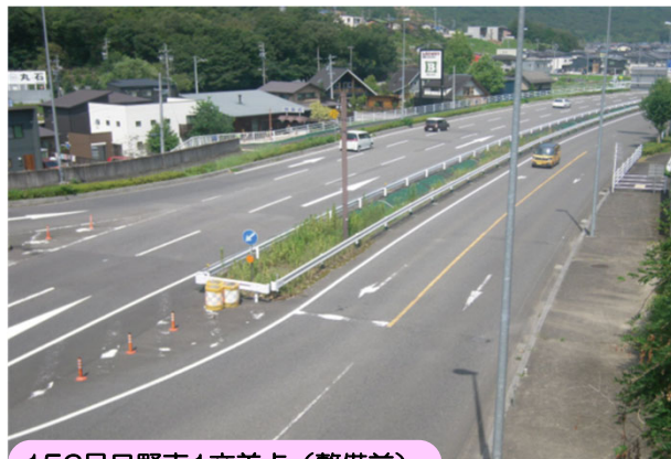
156号日野南1交差点（整備前）
