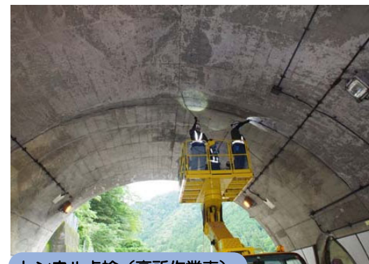
トンネル点検（高所作業車）
