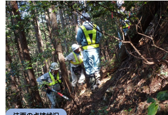
法面の点検状況
