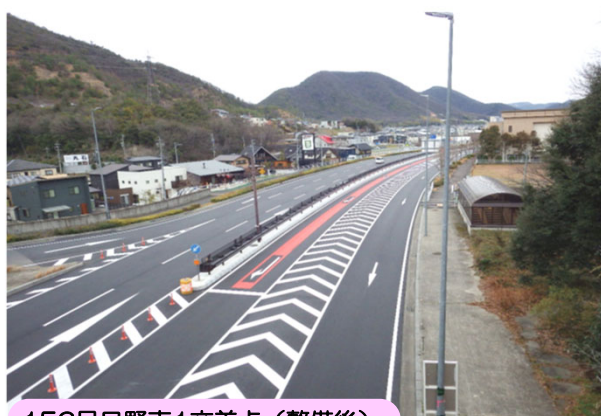
156号日野南1交差点（整備後）
