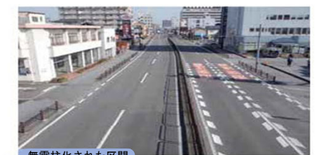
無電柱化された区間
