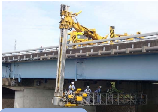
橋梁点検（橋梁点検車）
