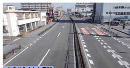
無電柱化された区間
