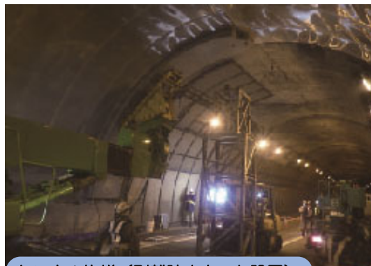
トンネル修繕（剥離防止ネット設置）
