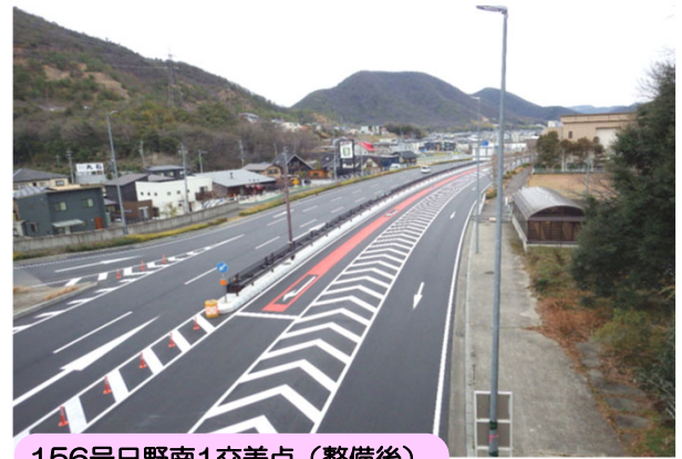
156号日野南1交差点（整備後）
