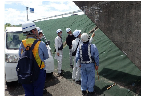
令和5年度橋梁点検講習会 (R5.7.31)
