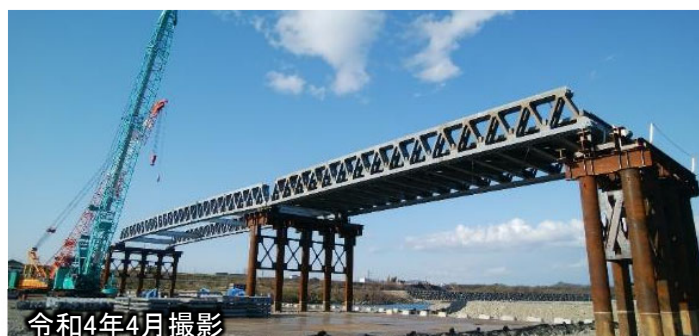
＜右岸側＞ 応急組立橋の施工状況
