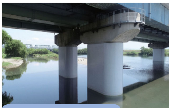
橋脚補強（コンクリート巻き立て）
