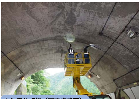
トンネル点検（高所作業車）
