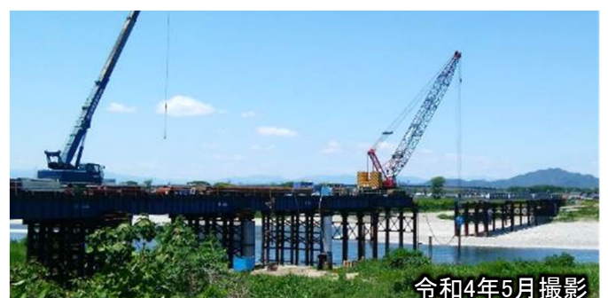
＜左岸側＞ 仮橋の施工状況
