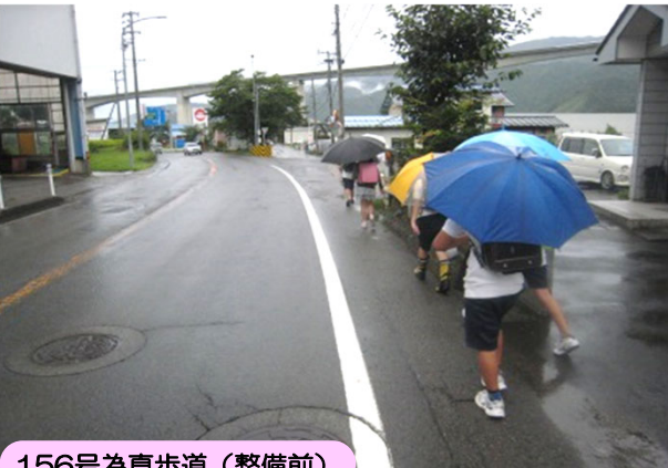
156号為真歩道（整備前）
