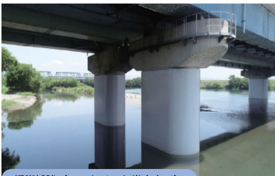
橋脚補強（コンクリート巻き立て）
