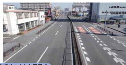
無電柱化された区間
