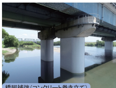
橋脚補強（コンクリート巻き立て）
