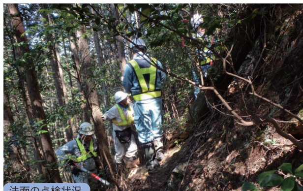
法面の点検状況
